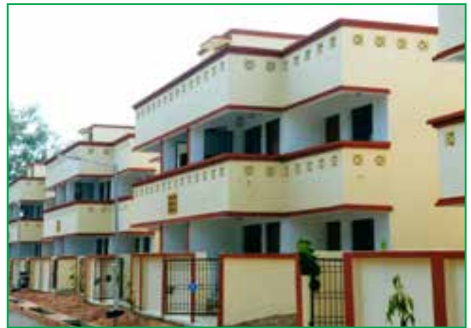
मॉयल के श्रम कल्याण योजना के तहत घरों का निर्माण
